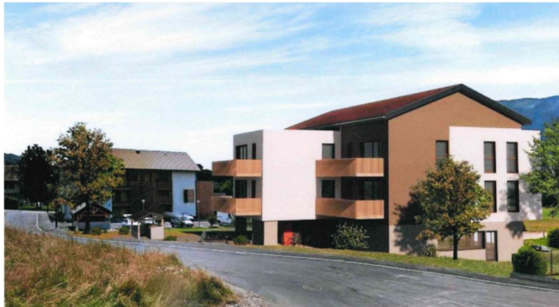
Installation de la boulangerie prévue au premier plan en rdc
